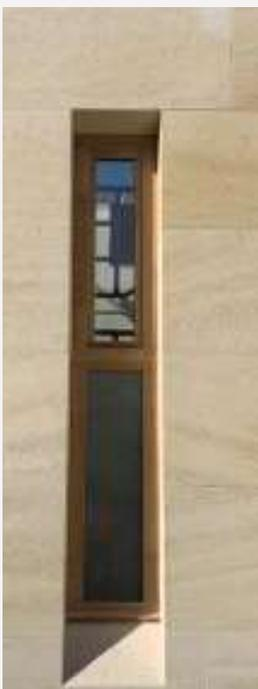
La respiration et la forte inertie de ce matériau épais, a l'avantage du stockage des calories et de leur lente restitution, favorable par cette régularisation hygrométrique à la thermique d'été, à un climat intérieur sain. Cette strate basse en pierre massive marque par son côté cyclopéen ce travail de socle et d'ancrage au sol du collègue.
