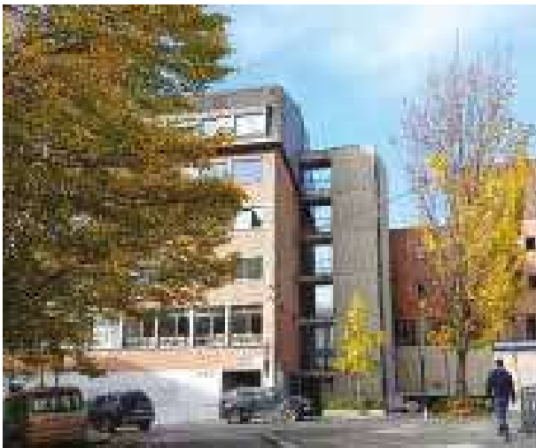
Sur la gauche, le bâtiment de la communauté et de la chapelle universitaire Notre-Dame de la Paix, rue Craffé, à Namur.
